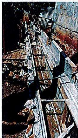
Photo 3 : Construction de l'évacuateur d'eaux pluviales
